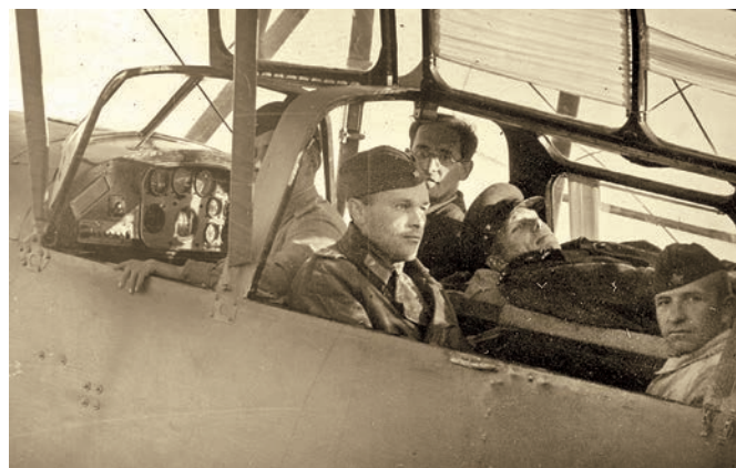
Размещение одного носилочного раненого по правому борту и двух сидячих — по левому в самолете По-2ШС
