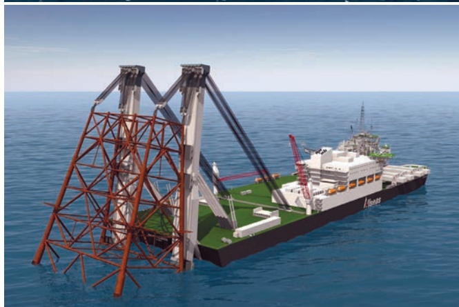
Рис. 10. Демонтаж основания морской платформы
