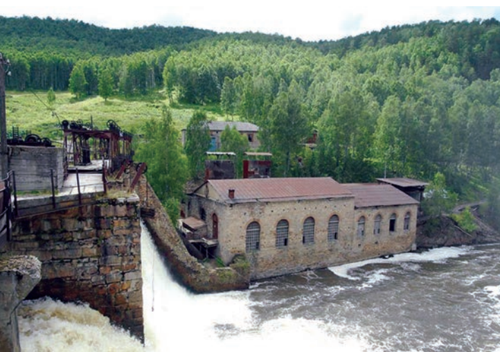
Рис. 4. Общий вид электрометаллургического завода «Пороги»
