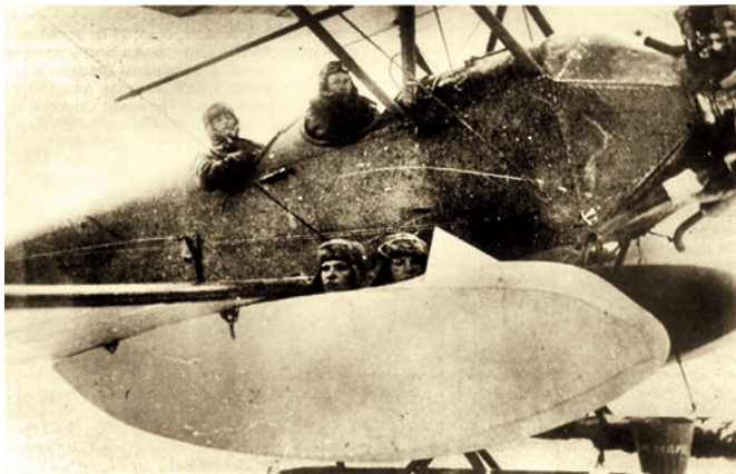
Размещение раненых в кассете А. Я. Щербакова под крылом самолета У-2
